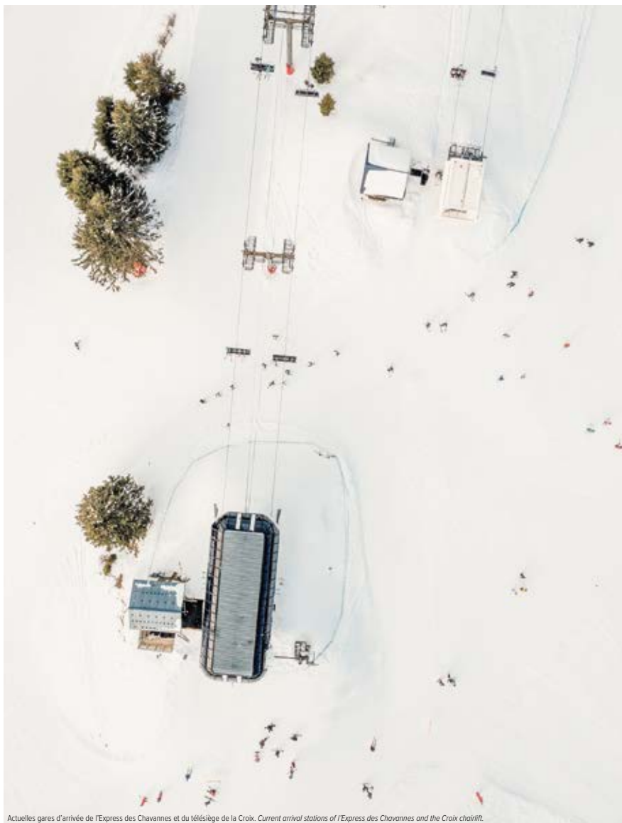
Actuelles gares d'arrivée de l'Express des Chavannes et du télésiège de la Croix. Current arrival stations of l'Express des Chavannes and the Croix chairlift.
