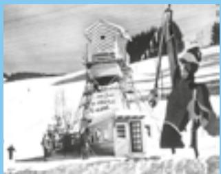
Le téléski de la Boule de Gomme a été installé en 1936. Les poulies et les perches étaient en bois, les sièges : des sièges de vélos ! Skilift de Boule de Gomme is in 1936 aangelegd. De polies en de stokken waren van hout, de stoeltjes: fietszadel!
