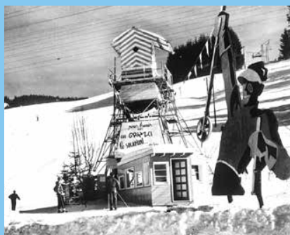
Le téléski de la Boule de Gomme a été installé en 1936. Les poulies et les perches étaient en bois, les sièges : des sièges de vélos ! Skilift de Boule de Gomme is in 1936 aangelegd. De poelies en de stokken waren van hout, de stoeltjes: fietszadels!
